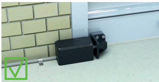
Grendel gemonteerd op de vloer.
